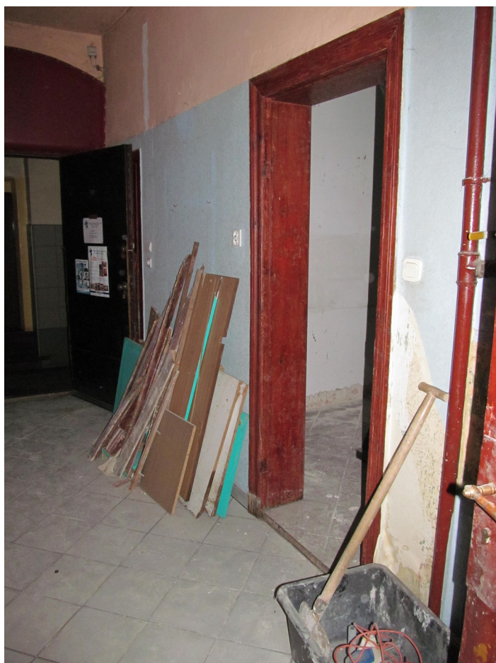
[Zdjęcie 5] Widok na ścianę konstrukcyjną nośną i otwór drzwiowy wewnętrzny, który przewiduje się poszerzyć obustronnie do szerokości 2,13m. Po wykonaniu zdjęcia dokonano odkrywki ukazującej beton istniejącego nadproża drzwi.
